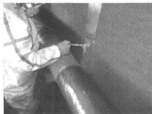
添架管塗裝修繕(平井集落)
