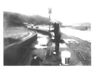
排水ゲート修繕(小坂堰地区)
