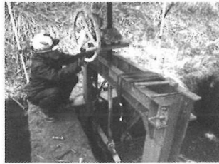
水穴堰開閉器修繕(別俣地区)
