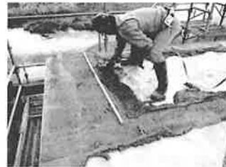
揚水機場屋根修繕(古町堰地区)
