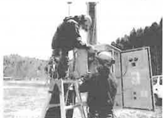
北浦ポンプ制御盤更新(北条地区)
