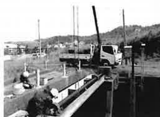
ゲート駆動部修繕(大崎集落)
