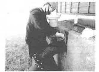
中部第4機場空気弁修繕(刈羽地区)
