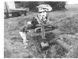
パイプライン漏水修繕(飯塚地区)
