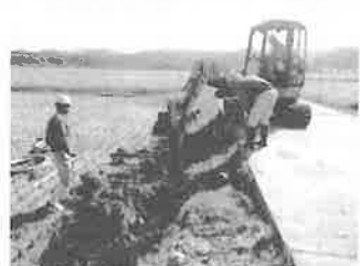
パイプライン漏水修繕(吉井地区)
