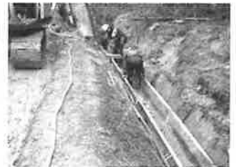
用水路吸出し修繕(大津地区)
