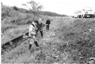
東江江浚・草刈作業(善根堰地区)
