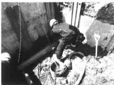
パイプライン漏水修繕(北鯖石東部地区)
