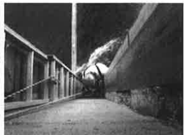
R1.6.18地震後の補修(古町堰地区)
