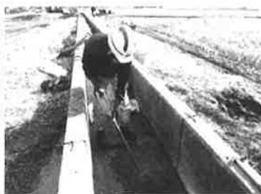
西江用水路漏水修繕(上原地内)
