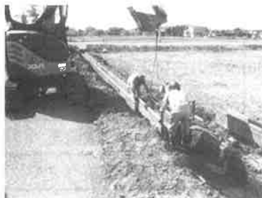
用水路伏せ替え工事
