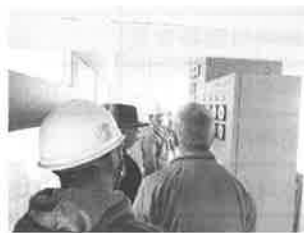
排水機場試運転(長嶺地区)
