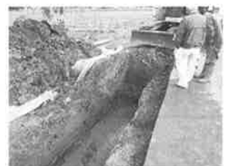
パイプライン漏水修繕(北野地区)
