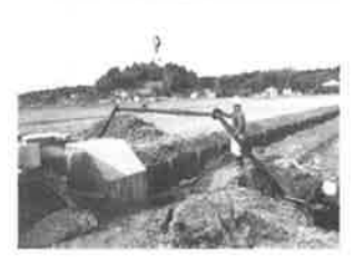
滝谷水管橋補修(刈羽地区)
