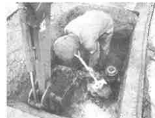
井岡空気弁樹補修(刈羽地区)
