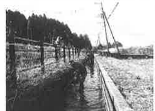
用水路江浚作業(古町堰地区)
