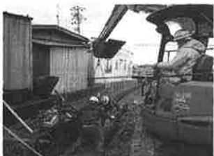
用水路布設替工事(田塚江)
