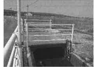
安全柵設置工事(高田地区)
