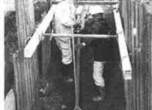
パイプ取替工事(刈羽地区)
