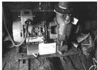
揚水機取替工事(宮之窪分一)
