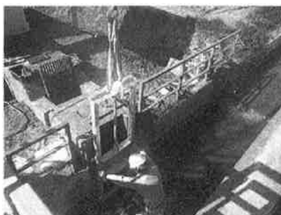
ゲート取替工事(北条地区)
