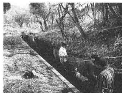
用水路江浚作業(善根堰地区)
