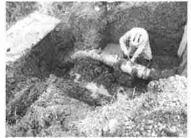
パイプライン漏水修繕工事(北碓部地区)
