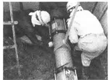
パイプライン漏水修繕工事(浜忠地区)
