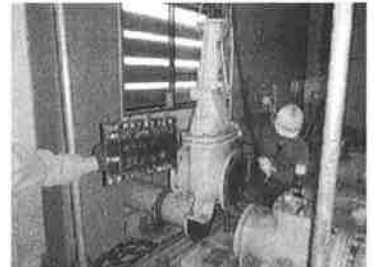
ポンプ吐出弁取替工事(刈羽地区)
