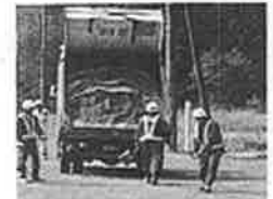
高原田工区（舗装復旧工）
