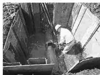
パイプライン漏水修繕工事(刈羽地区)
