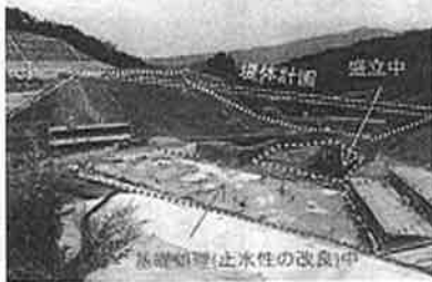
堰体下流施工状況
