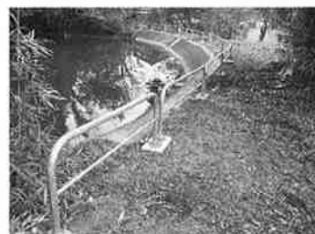
ため池安全柵設置工事(鎌田地区)
