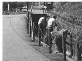
江浚作業(善根堰地区)
