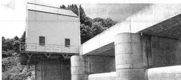
栃ヶ原ダム取水棟（湖面より）
