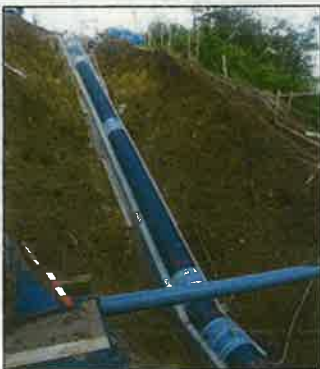
ダム天端の分水工につながる市野新田導水路の施工状況
