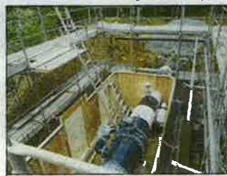
幹線導水路の施工状況 (宮川新田工区)
