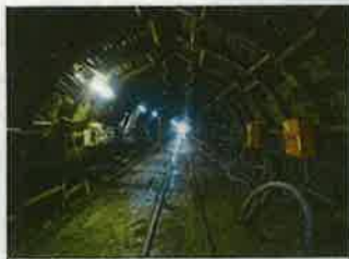
トンネルが貫通しました (坑内の状況)
