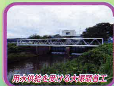
用水供給を受けるため、改修を行っている藤井頭首工
